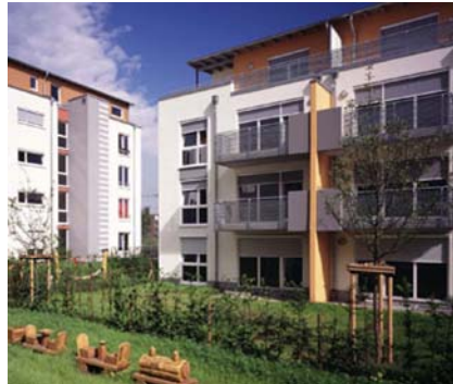
Autofreie Siedlung Stellwerk 60
